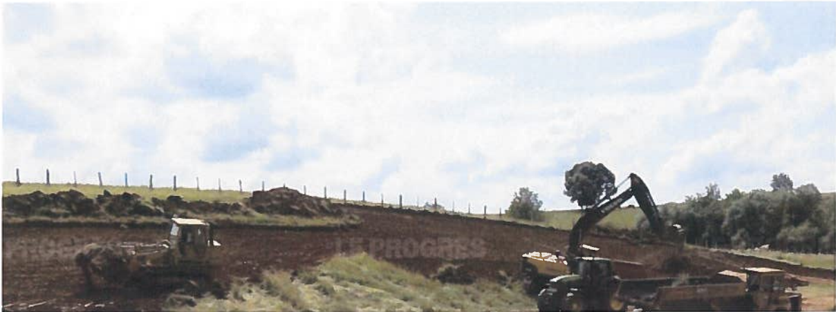
Première phase des travaux, l'entreprise Cadoux décape la terre végétale. Photo Emmanuelle BARBE
