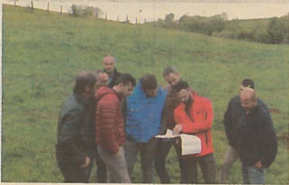
Visite de chantier relatif au lancement des travaux de l'unité de méthanisation de Gendrey
